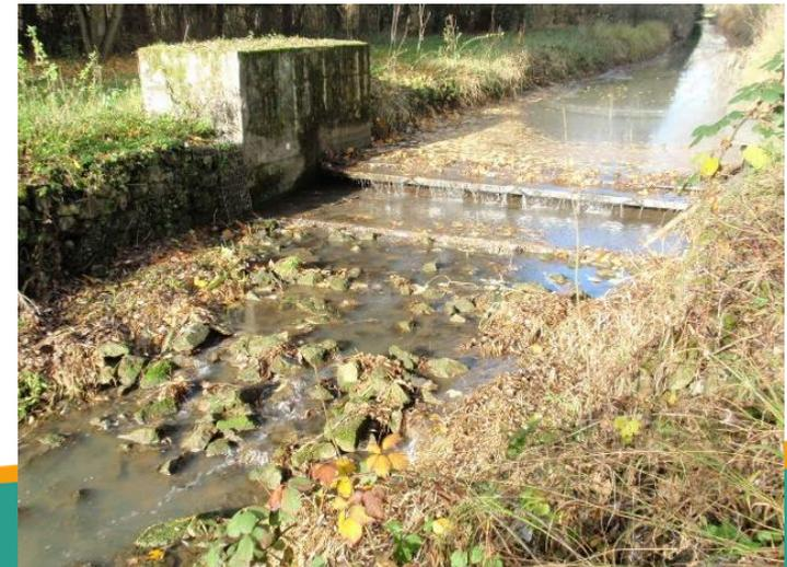
**Rivière de contournement** : relie l'amont de l'ouvrage à la zone aval par la création d'un chenal en pente douce pour permettre le passage des poissons.
