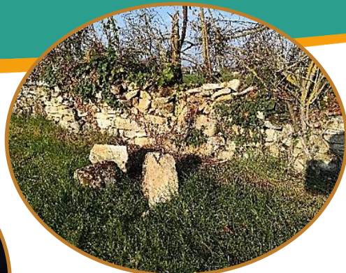
Restauration murs de pierres sèches
