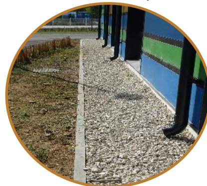
Gestion eaux pluviales
